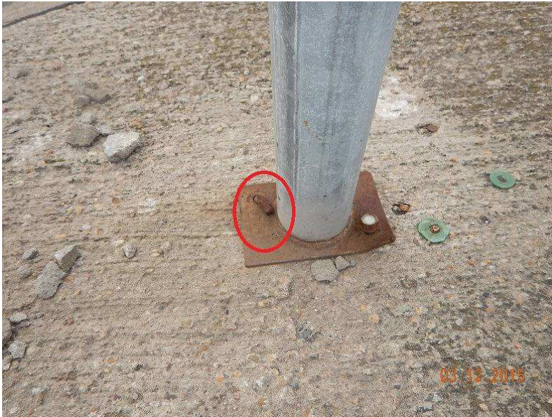
3546231_0_15H_FUTTERBELCH NICHT GESICHERT
