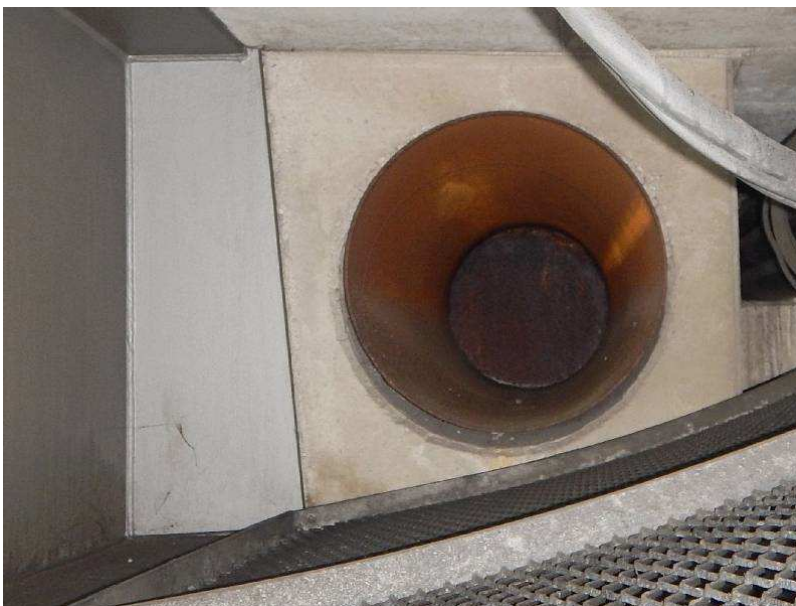
3546231_0_15H_ROHRDURCHFÜHRUNG VERROSTET
