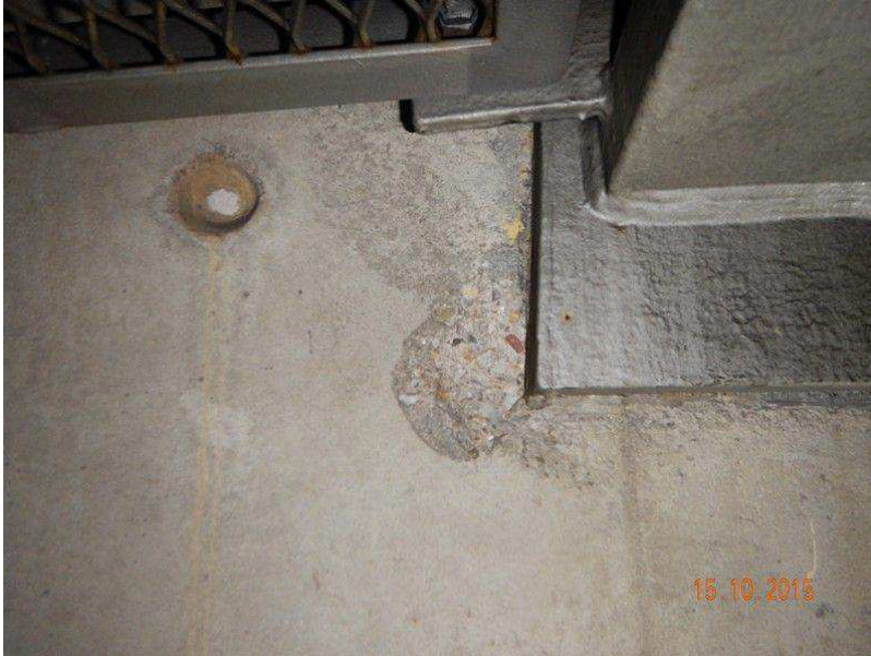
3546231_0_15H BETONABPLATZUNG
