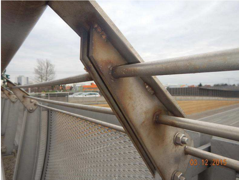
3546231_0_15H_GELÄNDER ANGEROSTET
