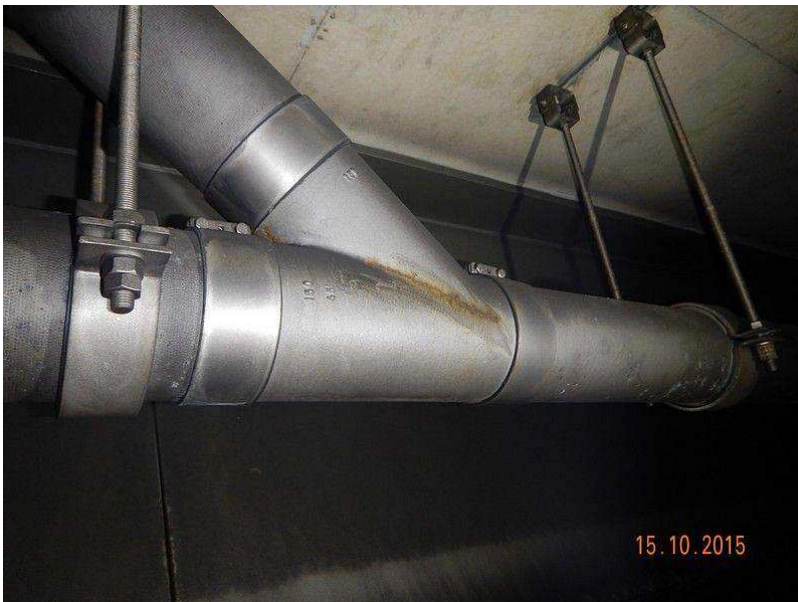
3546231_0_15H_ENTWÄSSERUNGSRÖHR ANGEROSTET
