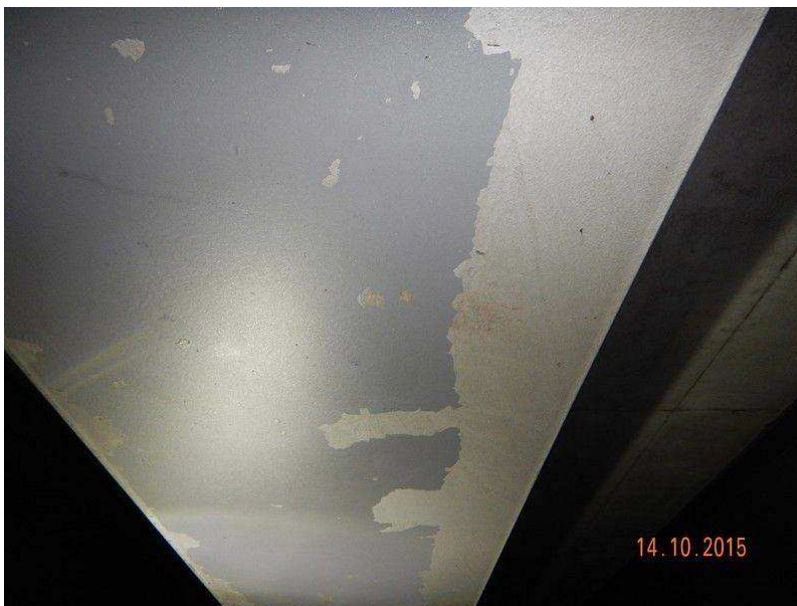
3546231_0_15H_DECKBESCHICHTUNG ABGEBLÄTTERT
