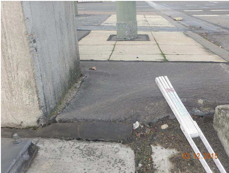
3546231_0_15H_AUFWULSTUNG DES BELAGES
