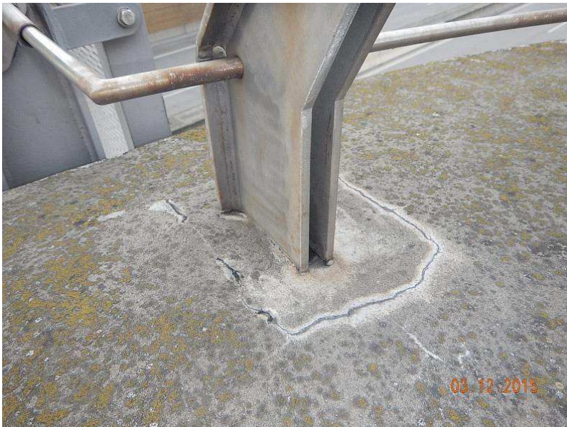
3546231_0_15H_PFOSTENVERGUSS RISSIG
