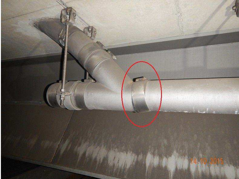
3546231_0_15H_BEFESTIGUNGSSCHELLE SCHRÄG
