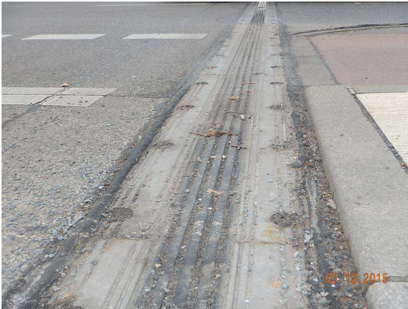
3546231_0_15H_BESCHICHTUNG ABGEFAHREN
