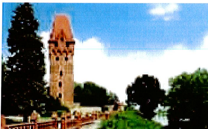
Kapitelsturm in Tangermünde
